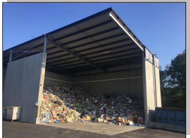
Bâtiment de stockage des emballages recyclables
